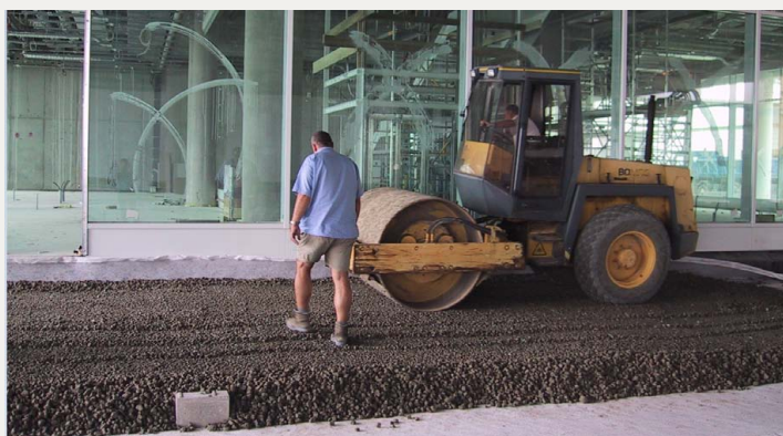
Verdichtung mit Walze oder Rüttelplatte
