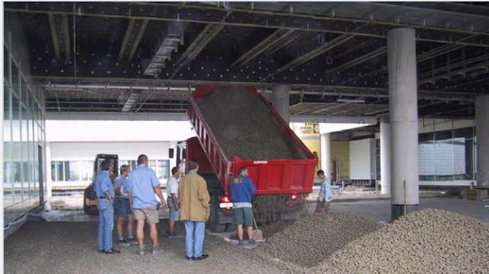
Transport vom Mischwerk zur Baustelle
