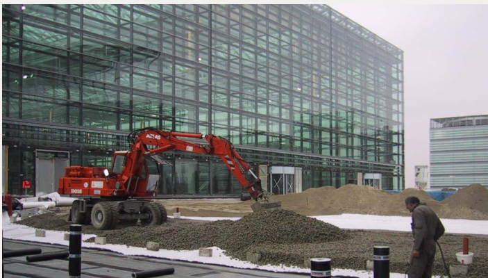
Materialeinbau und Verteilung mit Bagger
