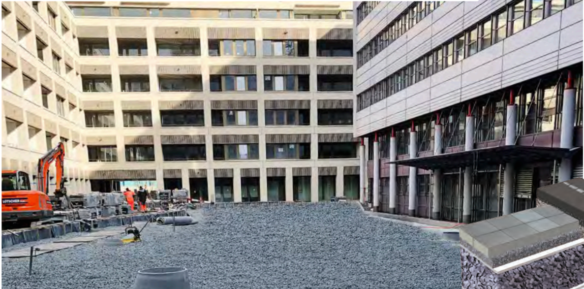
MISAPOR-Leichtschüttung mit befahrener Fläche über einer Tiefgarage in CH-6005 Luzern
