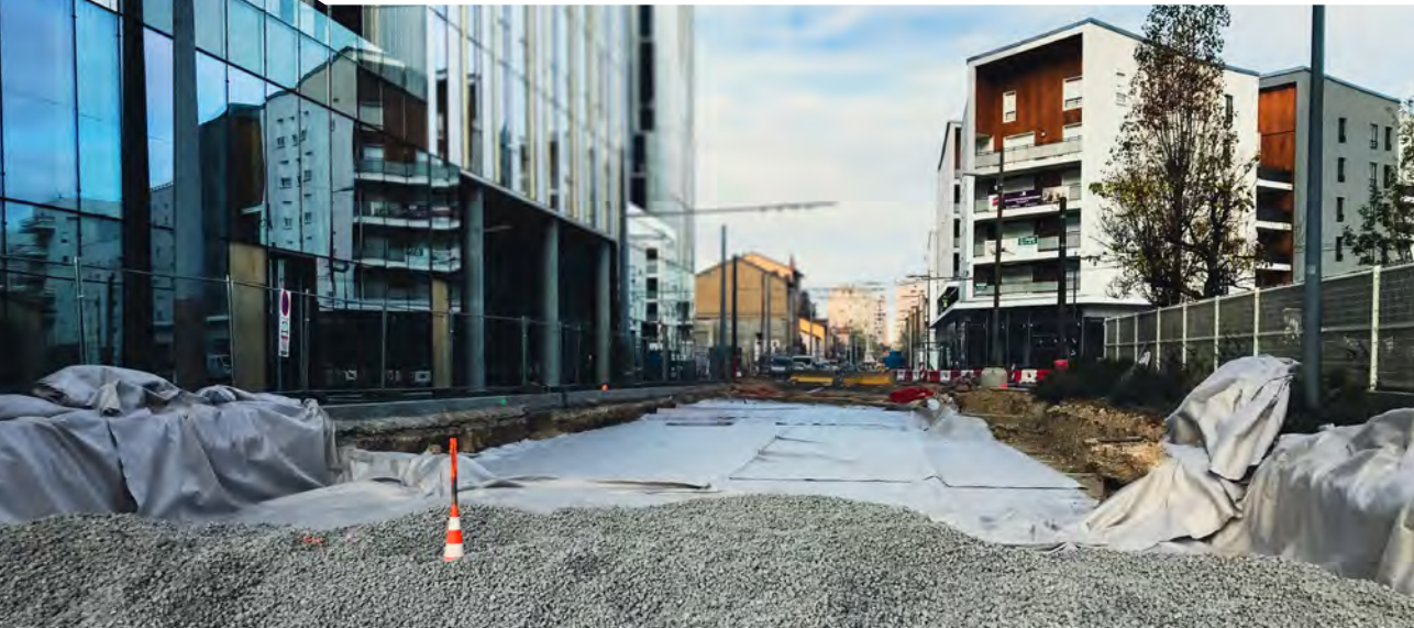
Leichtschüttung auf einem Metrotunnel in FR-69100 Villeurbanne
